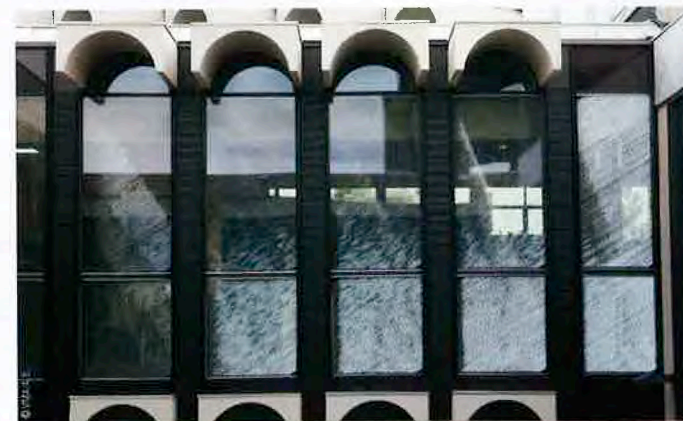
Effet miroir et création de nouvelles perspectives, les façades prennent vie avec les murs-rideaux Geode de Technal et les vitrages ImmoBlade MiniStore avec BSO intégrés venant synchroniser les variations de la trajectoire solaire ; en parfaite harmonie avec la sobriété de l'ouvrage.
